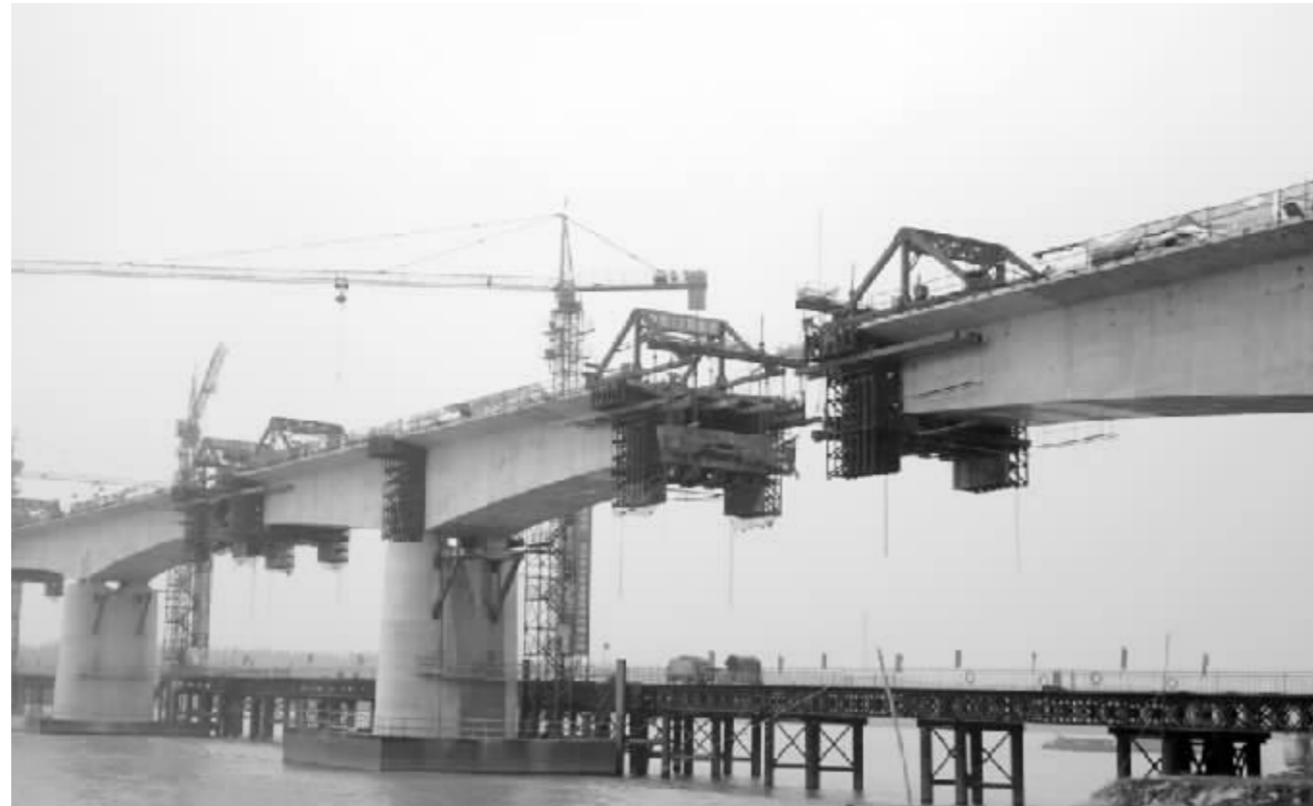
重大基础设施投资发挥着拉动经济增长最直接、最有效的作用。图为进入合龙阶段的京沪高铁淮河特大桥主桥 新华社图
